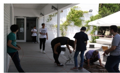
Foto 6: Enfiamento de guias em conduta existente
