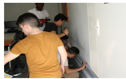
Foto 3: Colocação de calha técnica numa das paredes
